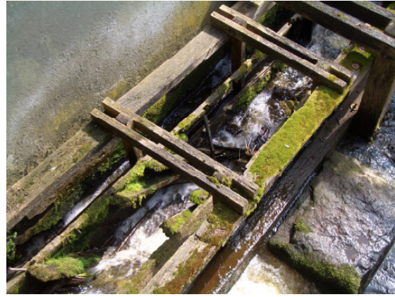
Abbildung 2-8: Draufsicht Denilfishpass
