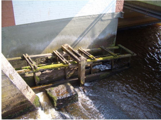
Abbildung 2-7: Seitenansicht Denilfishpass
