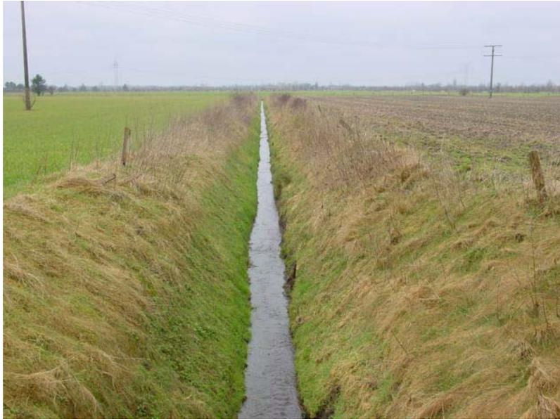
**Abb. 4.1.5.5-2: Begradigtes und querschnittsverändertes Gewässer**
