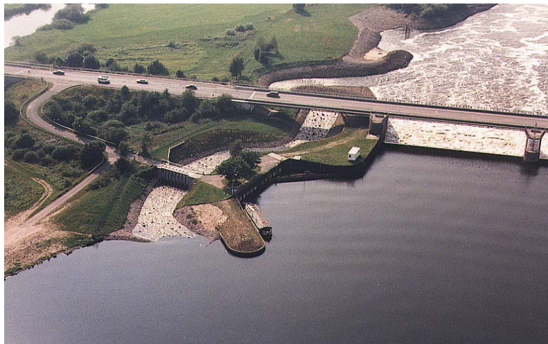
Abb. 4.1.5.4-1: Wehr bei Geesthacht mit Umgehungsgerinne für den Fischaufstieg
