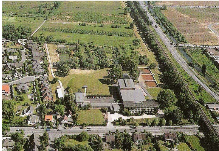
Abb. 4.2.3.3-2: Wasserwerk Süderelbmarsch / Harburger Berge
