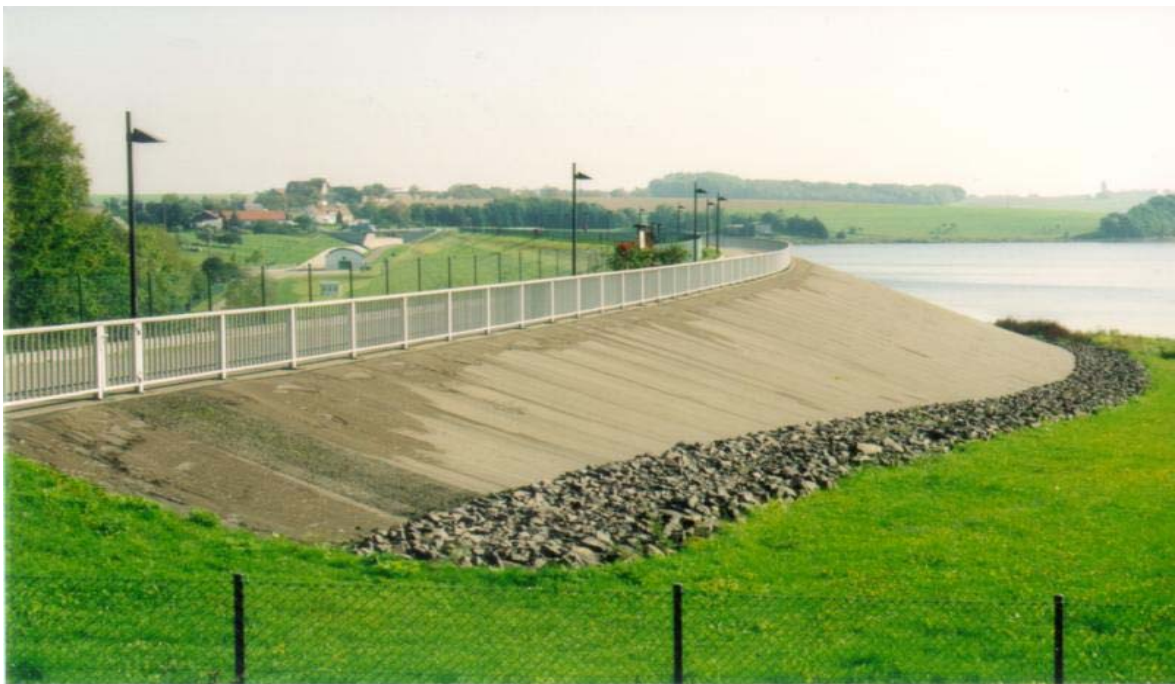
Abb. 4.1.5.4-1: Talsperre Schömbach im Bearbeitungsgebiet Weiße Elster
