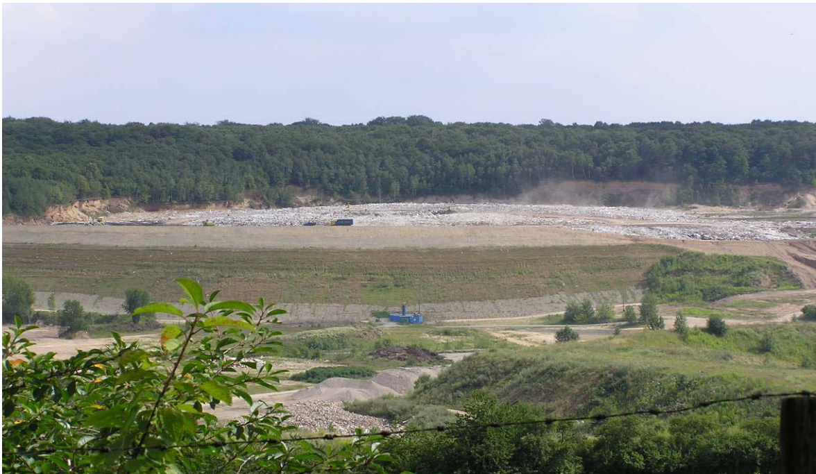
Abb. 4.2.3.2-1: Deponie im Bearbeitungsgebiet Untere Saale
