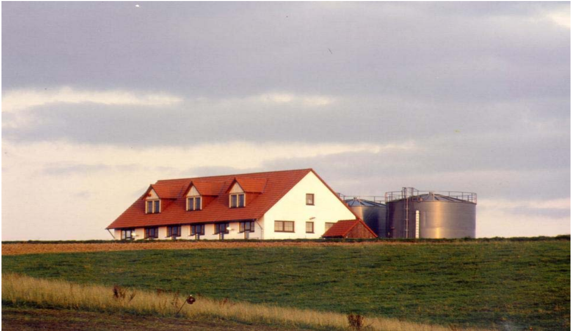
Abb. 4.2.3.3-2: Wasserwerk Rathendorf im Bearbeitungsgebiet Weiße Elster
