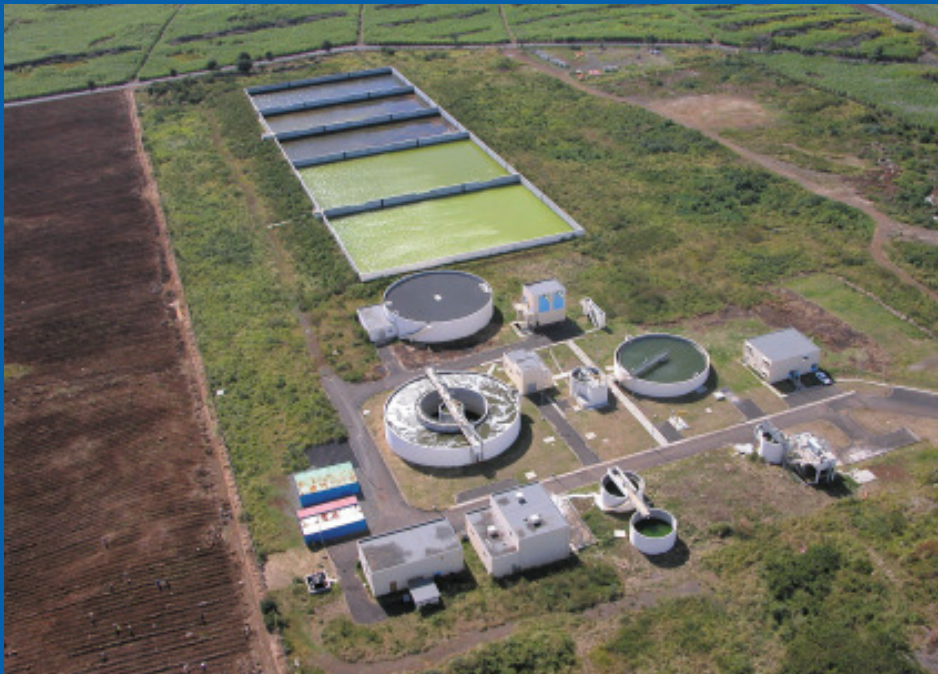
Abwasserreinigungsanlage Grand Baie
