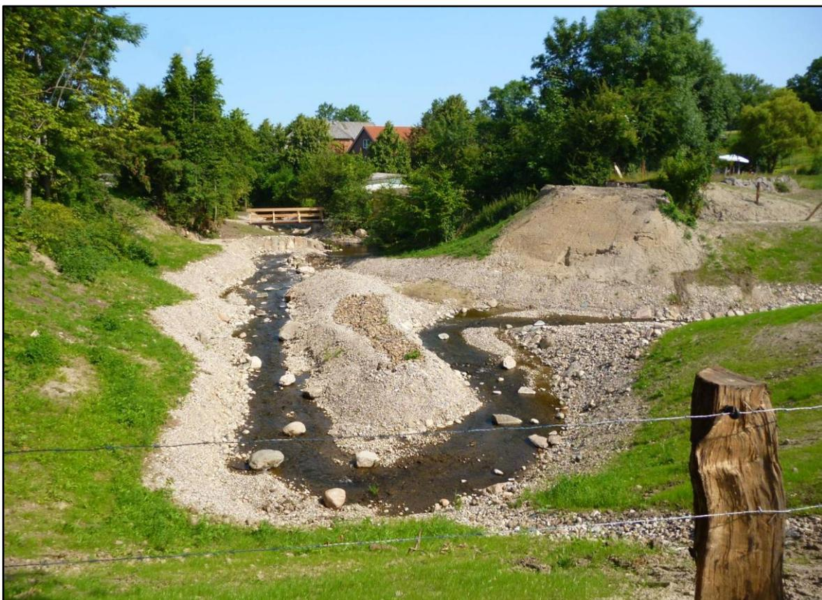
Abb. 13: Bau eines Umgehungsgerinnes in der Mühlenau bei Futterkamp nach Abschluss der Bauphase
