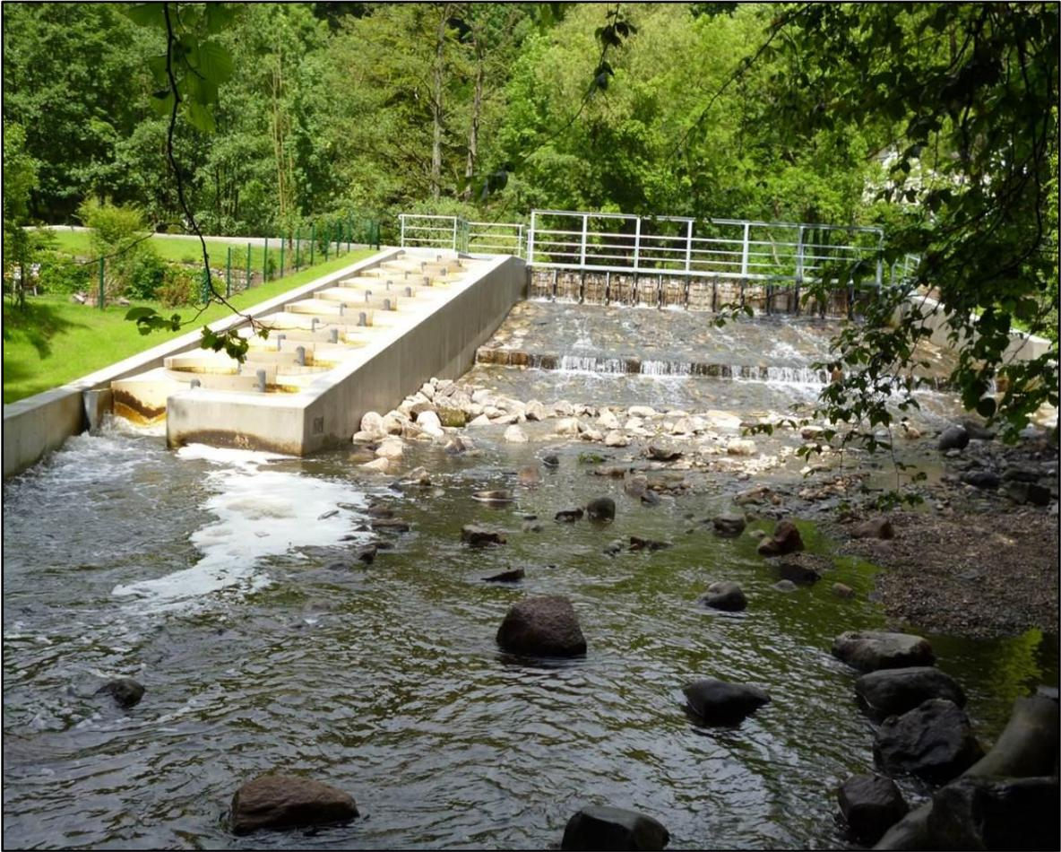
Abb. 14: Bau eines Mäanderfischpasses in der Schwentine an der Wehranlage in Raisdorf
