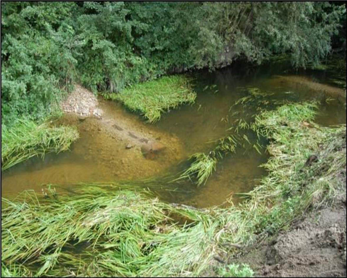
Abb. 15: Einbau von Strömunglenkern an der Schwartau
