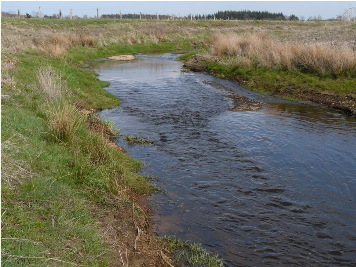
Abb. 10: Beispiele für die Verbesserung der linearen Durchgängigkeit in der FGE Eider (Laufverlängerung Ostenau)
