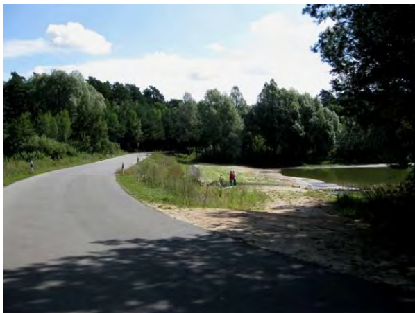
Abbildung 41: Damm des Mühlenteichs mit Fahrstraße aus Richtung Bork gesehen. Der Mühlenteich befindet sich am linken Bildrand, der Obersee am rechten Bildrand; zu sehen ist das Auslassbauwerk sowie Reste der Baustraße (Foto W. Ostendorp, 14.08.2012).
