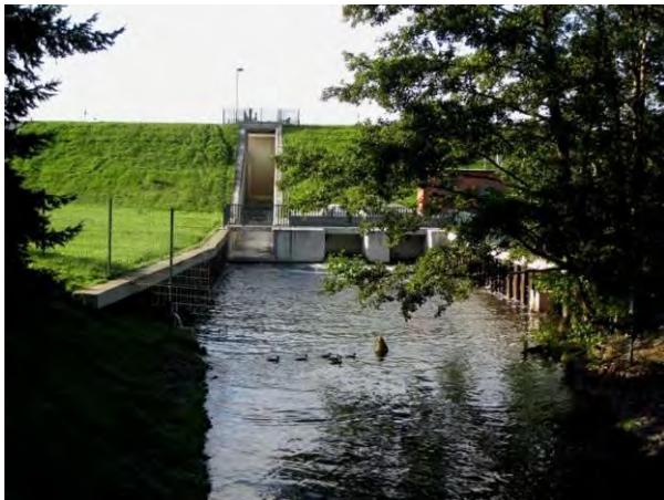
Abbildung 48: Auslassbauwerk des Dossespeichers (Obersee) (Foto: W. Ostendorf, 12.08.2012)
