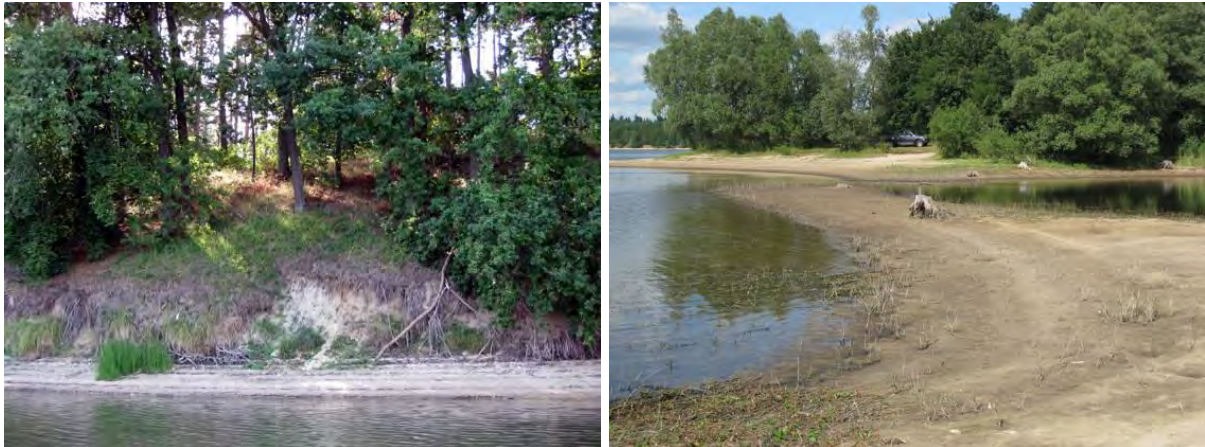
Abbildung 57: Beispiele für die Uferformen des Obersees: links – steilschariges Geschiebeufer mit eingeschnittenem aktiven Kliff im mMW und mHW-Bereich und Hangrutschungen; am Fuß des Hangs bildet sich eine neue Brandungsplattform aus (Nordwestufer, 13.08.2012, Wasserstand 38,98 m NHN, entspr. 0,56 m unter mMW); rechts – flachschariges Geschiebeufer mit erheblicher Feststoffumlagerung und ufermorphologischen Dynamik (hier: Anlagerung einer Berme) mit spärlichen Schwimmblatt- und Schlammfluren und Silberweiden-Auewald (Ostufer, 12.08.2012, Wasserstand 39,00 m NHN; alle Fotos: W. Ostendorp).
