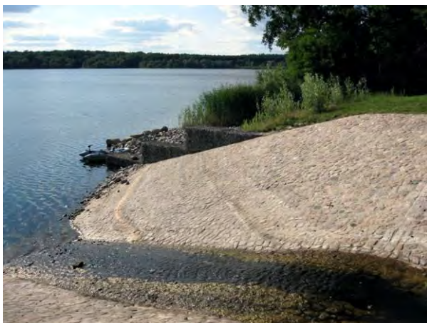
Abbildung 46: Zulaufbauwerk des Dosse- Zuleitungskanals in den Obersee (Foto: W. Ostendorp, 12.08.2012)
