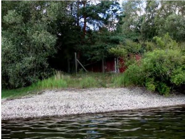
Abbildung 47: Seewasserentnahme am Westufer des Obersees für die Kyritzer Abwasserbehandlungsanlagen. Zu sehen sind das Betriebsgebäude sowie die Ufersicherung aus Kies (Foto: W. Ostendorf, 12.08.2012)
