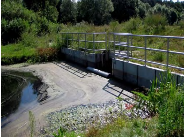
Abbildung 44: Auslassbauwerk des Mühlen- teichs unter dem Verkehrsdamm Bork. Die dunkle Färbung des Betons kennzeichnet den Maxi- malwasserstand von 2011/12 (Foto W. Ostendorp, 14.08.2012)
