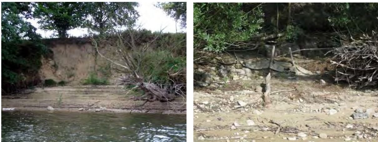
Abbildung 78: links – ein etwa 2,5 m hohes Kliff in standfestem lehmigem Sand am Westufer des Obersees südlich Bork; rechts – Reste einer älteren ingenieurbioologischen Ufersicherung am Ostufer des Obersees (Fotos: W. Ostendorp vom 12. u. 13.08.2013 bei einem Wasserstand von 399,00 bzw. 398,98 m ü. NN, d. h. 0,54 m bzw. 0,56 m unter mMW).
