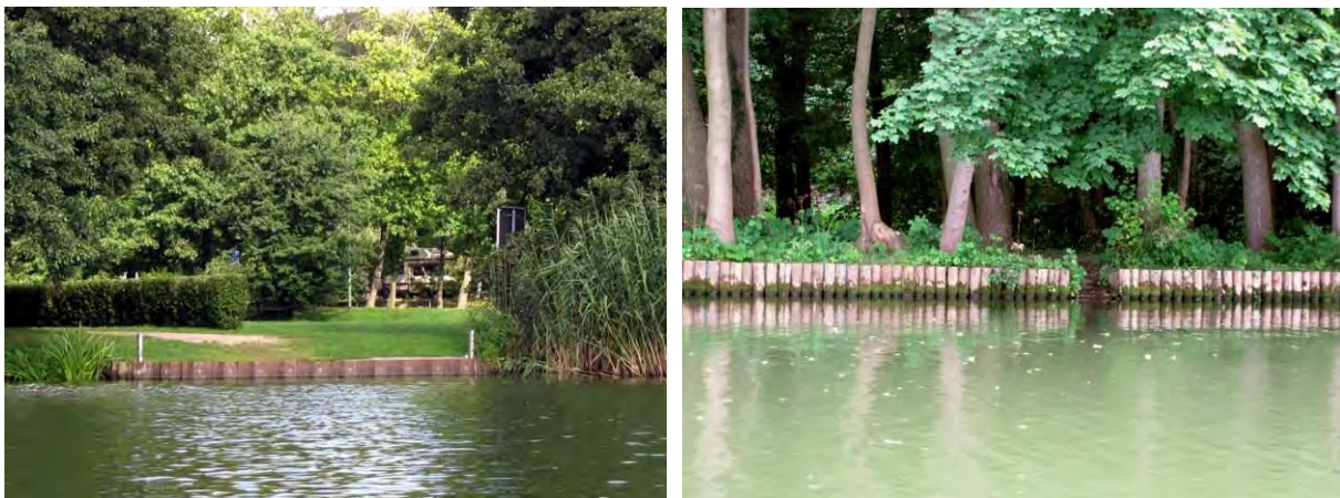
Abbildung 77: links – Spundwand an der Löschwasserentnahmestelle Kyritz-Waldkolonie am Ostufer des Untersee; rechts – Palisade aus Kiefernstämmen bei der Klempowmühle (Wusterhausen) am Südostufer des Untersees (Fotos W. Ostendorp, 15. u. 16.08.2012).
