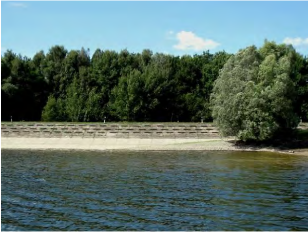
Abbildung 42: Hochwasserschutzdamm am Südufer des Obersees (Stolper See). Am rechten Bildrand aufgeschüttetes Kiesmaterial mit einer jungen Silberweide ( Salix alba ); ansonsten wird der Damm auch bei Niedrigwasser vom Seespiegel erreicht. Im Hintergrund sind die naturnahen Feuchtwälder der ehemaligen Seeniederung zu erkennen (Foto: W. Ostendorf, 12.08.2012)
