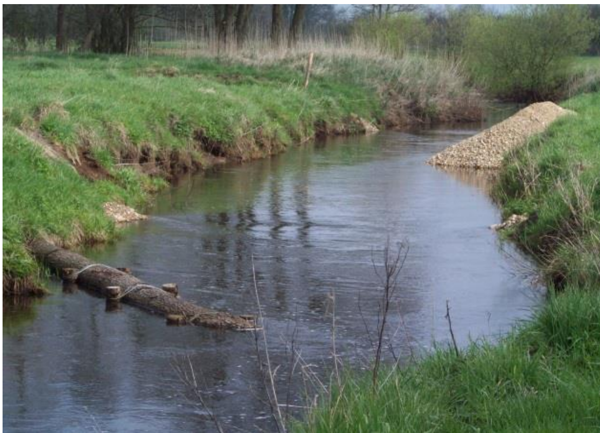
Abb. 10: Totholz- und Kiesdepoteinbau in der Jevenau (we_09)
