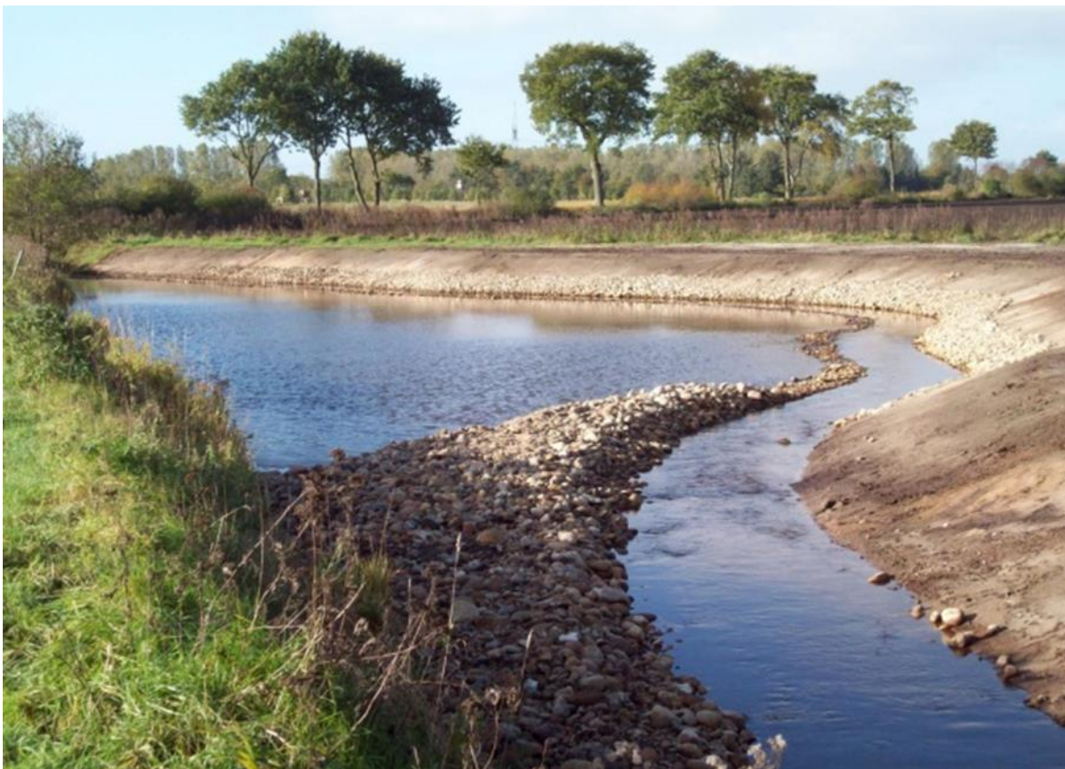
Abb. 15: Naturnaher Sandfang in der Bredenbek (ost_10_a)
