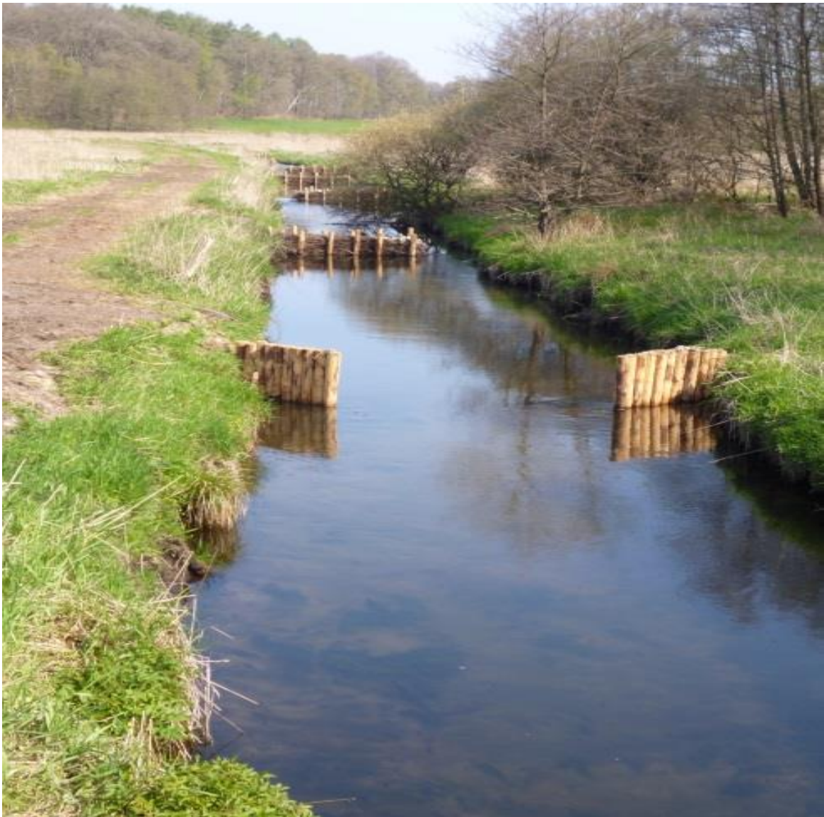
Abb. 83: Strömungslenkende Maßnahmen an der Rantzau
