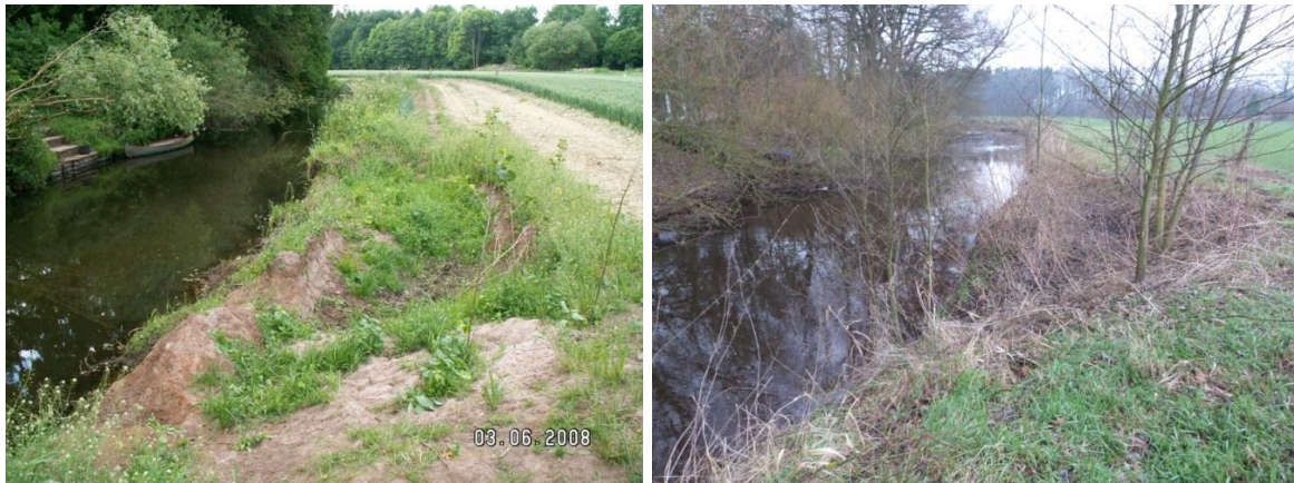
Abb. 74: Entwicklung einer Pflanzberme in einem Zeitraum von ca. 5 ½ Jahren
