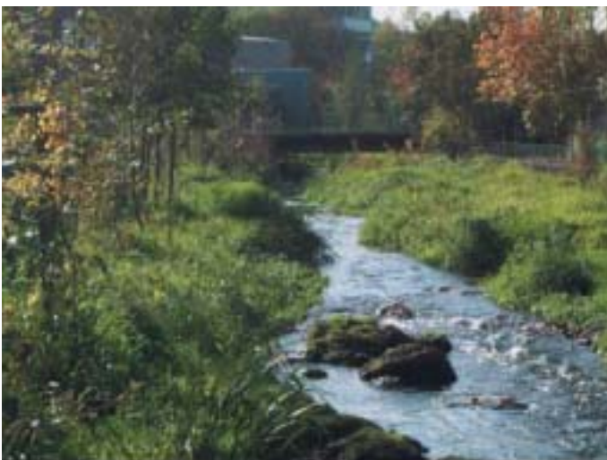
Bild 2: Sanierter Bereich mit vielfältigen Ufer- und Sohlensubstraten sowie mit verbessertem Hochwasserabfluss (Foto: WASSER-MÜLLER Ingenieurbüro GmbH)
