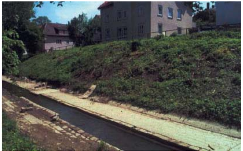
Bild 1: Das kanalartige, im betonierten U-Profil fließende Gewässer vor der Umgestaltung (Foto: WASSER-MÜLLER Ingenieurbüro GmbH)
