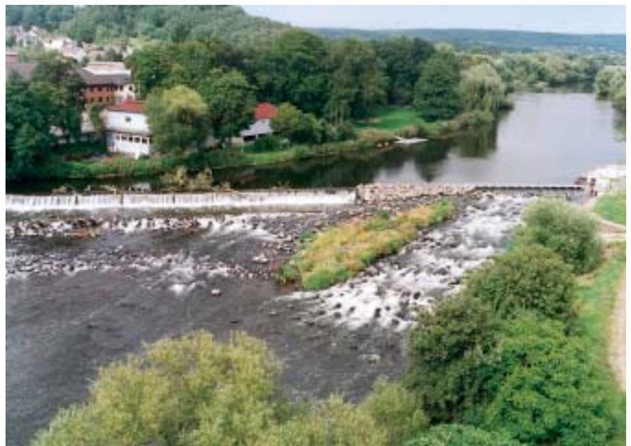
Bild 1: Wehr in Siegburg-Buisdorf mit Fischaufstiegsanlage, Kontroll- und Fangstation für Fische (Foto: E. Städtler)
