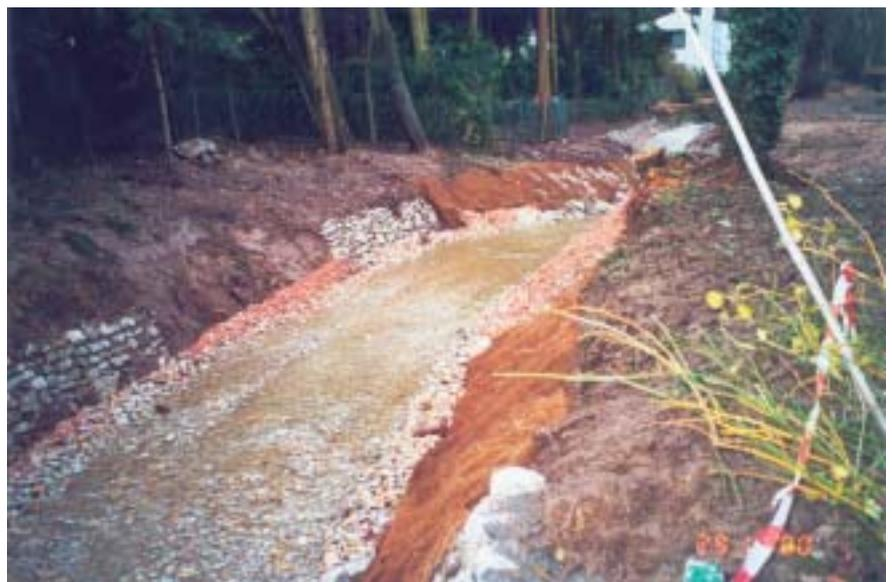
**Bild 3: Naturnahe Bachsohle mit Böschungsfußsicherung und punktueller Ufersicherung durch Natursteinmauerwerk vor Bepflanzung und Einsaat der Rasenmischung (Januar 2001)**
