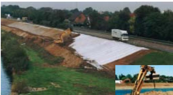
**Bild 3 + 4: Einbau von Bentonit-Dichtungsbahnen entlang der B 28 bei Neumühl**
