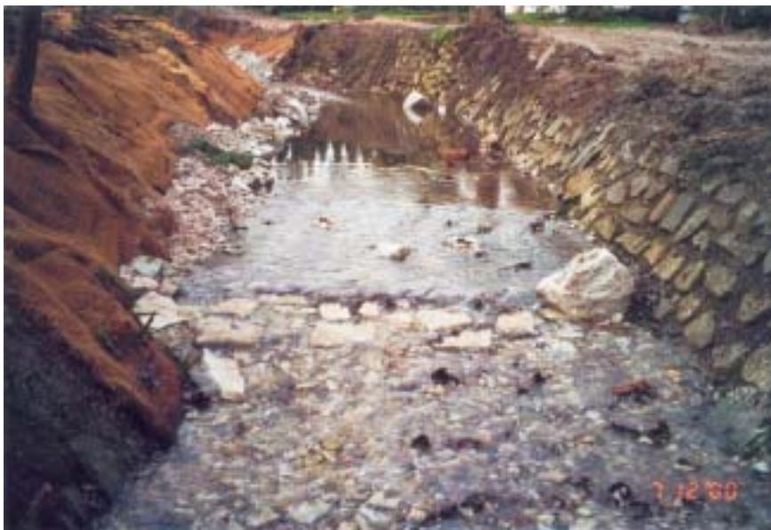
**Bild 2: Fixierung der Sohle mit Sohlengurten aus Holzpfahlreihen und Steinsatz (Dezember 2000)**
