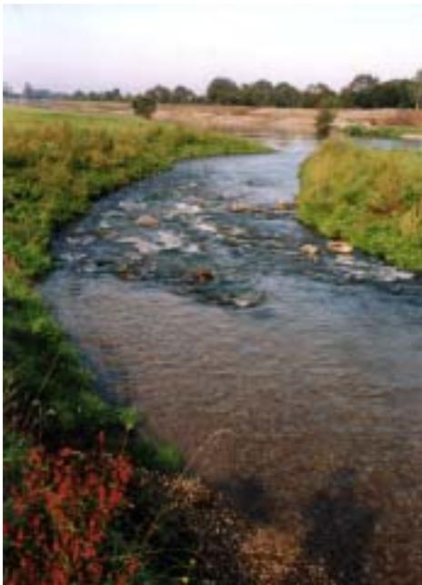
**Bild 8: Neue Schuttermündung mit Rauer Rampe**
