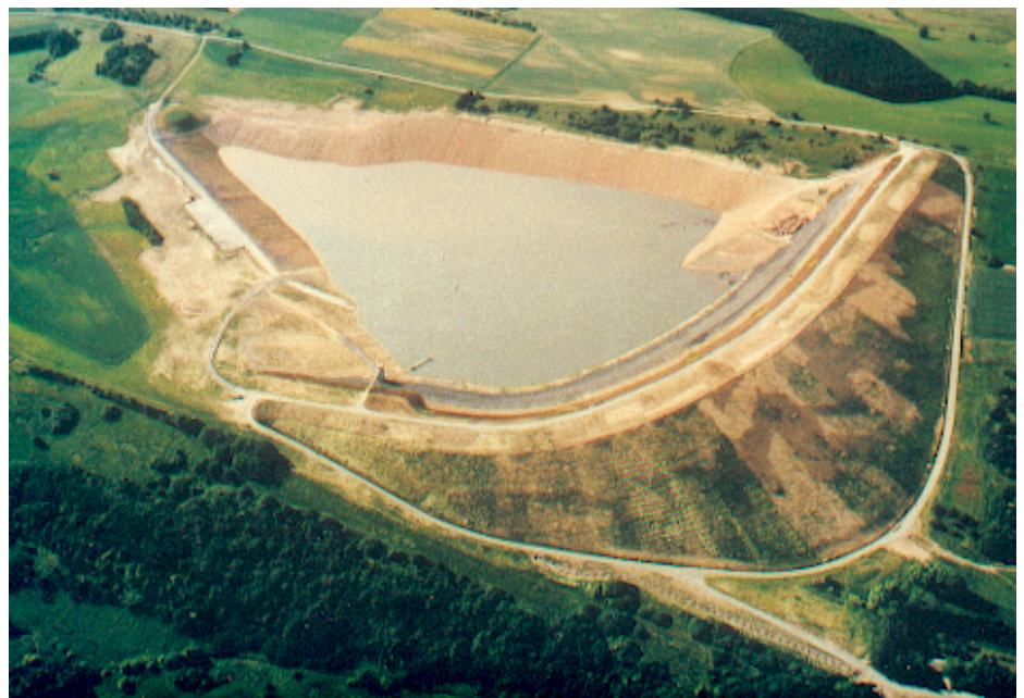
Ansicht eines Sedimentationsbeckens mit Talsperrencharakter
