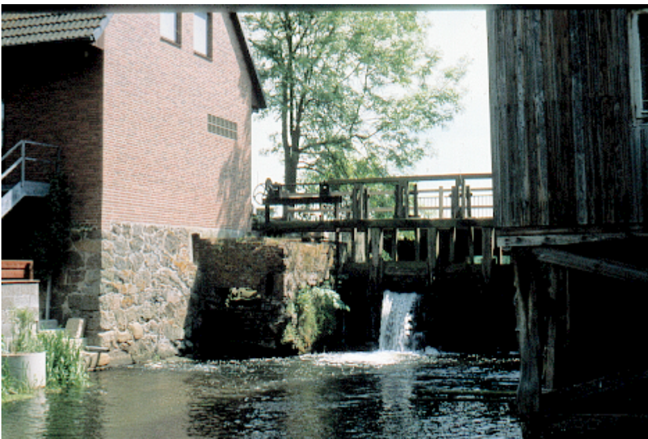
Mühle in Neetze (Lkr. Lüneburg). Unterbrechung der ökologischen Durchgängigkeit durch eine Wehranlage. (Foto: I. Dahlman)
