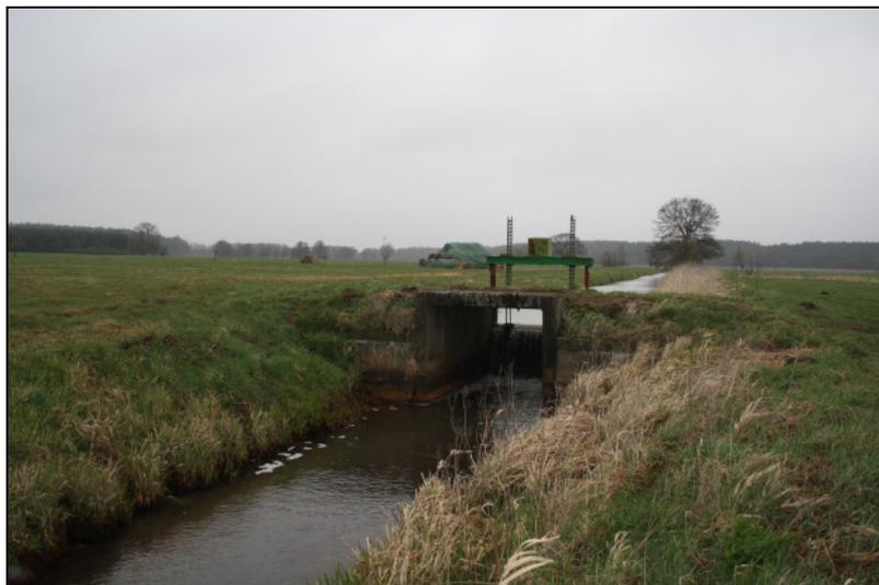
**Abbildung 76:** Nicht durchgängiger Fließgewässerabschnitt der Karthane bei km stat. 41+200 mit einem hohen Absturz durch die Stauhaltung (Foto: FuK, 07.04.2012)
