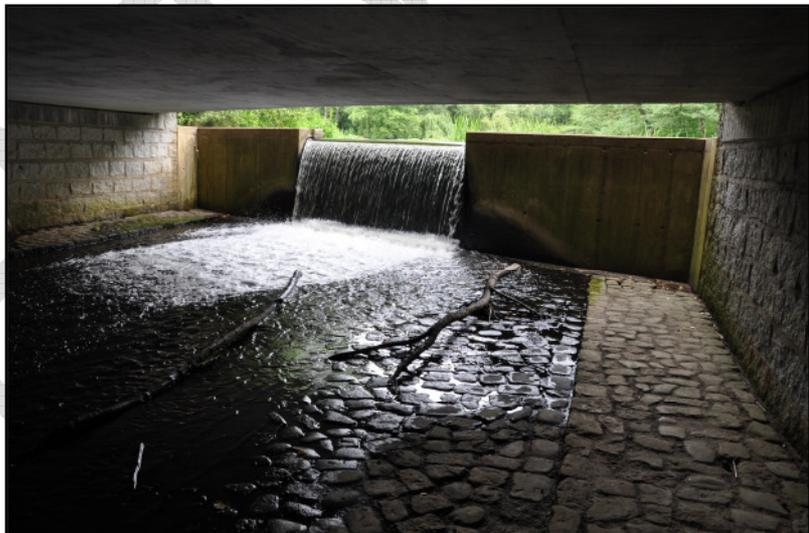
**Abbildung 83: Wanderhindernis und Sedimentfalle am Cederbach in Hoppenrade, km stat. 13+900 (Foto: FPB GmbH, 06.06.2012)**
