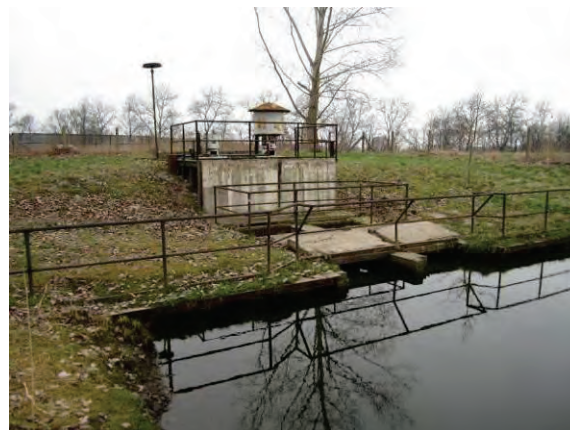
Abbildung 78: Schöpfwerk Albertsheim (P01)
