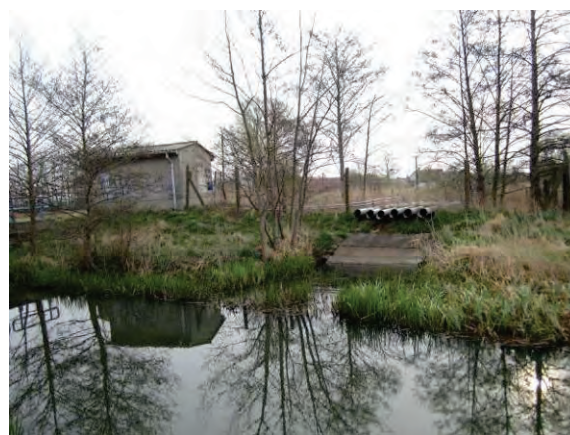
Abbildung 33: Pumpwerk in den Königsgraben
