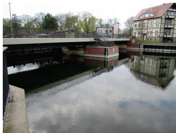
Abbildung 66: Wehr und Straße bei 1+200
