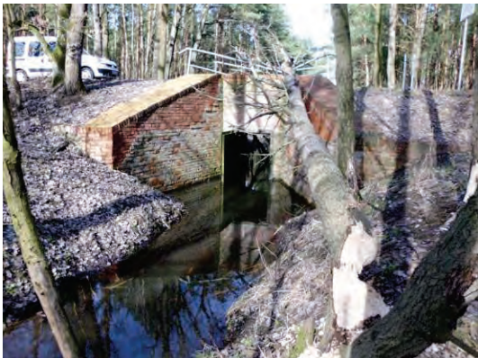
Abbildung 94: P05 Absperrbauwerk im Deich
