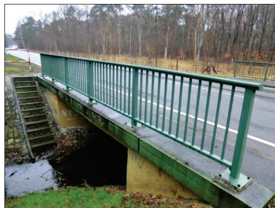
Abbildung 51: Straßenbrücke B102 (P02)
