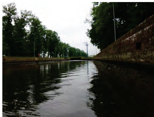
Abbildung 88: Abschnitt P06, total verbauter Gewässerlauf im Schleusenbereich Garz
