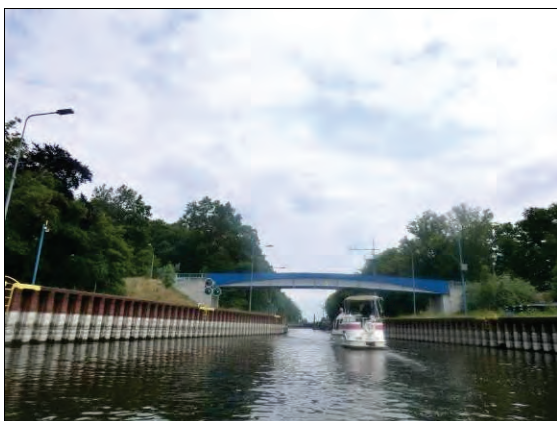
Abbildung 54: Ein- und Ausfahrtsbereich der Schleuse
