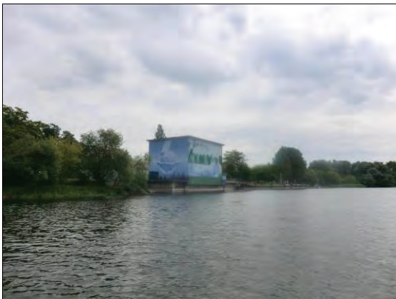
Abbildung 40: Pumpwerk in Premnitz
