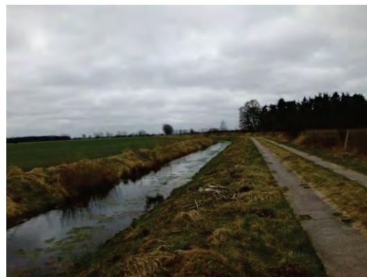
Abbildung 86: Abschnitt P04, niedrige Wasserstände mit umliegender ackerbaulichen Bewirtschaftung
