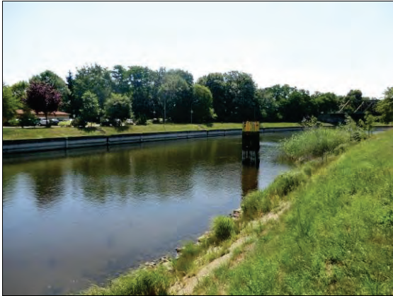
Abbildung 38: Schleuse in Rathenow
