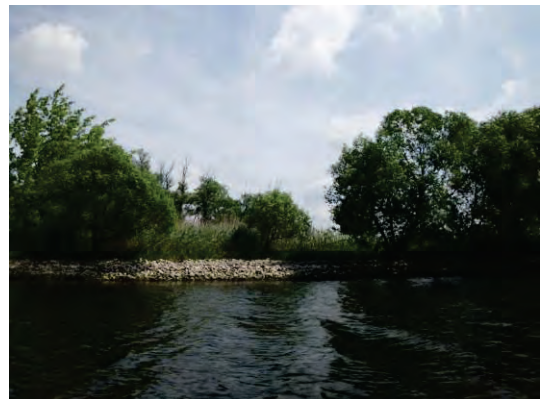
Abbildung 43: offenes Deckwerk, Planungsabschnitt P24
