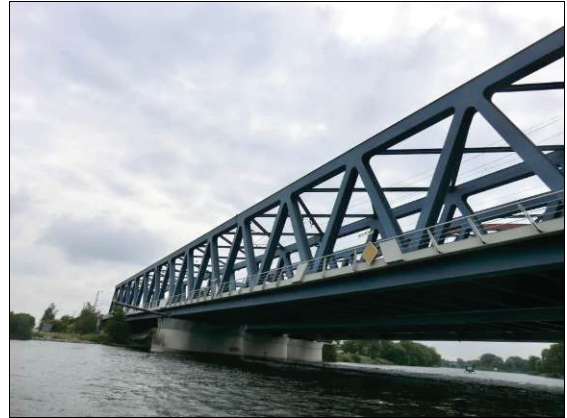
Abbildung 39: Eisenbahnbrücken I und II sowie Straßenbrücke B189 (Rathenow)
