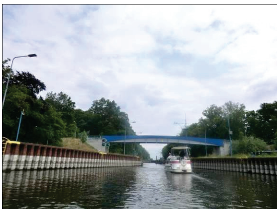
Abbildung 54: Ein- und Ausfahrtsbereich der Schleuse
