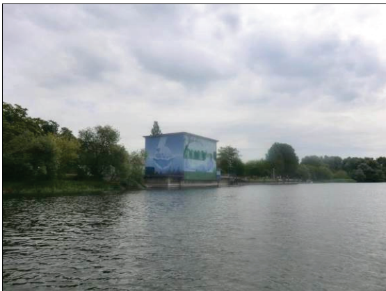
Abbildung 40: Pumpwerk in Premnitz
