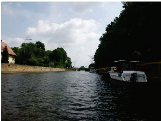
Abbildung 42: Schleuse in Grütz, Planungsabschnitt P20
