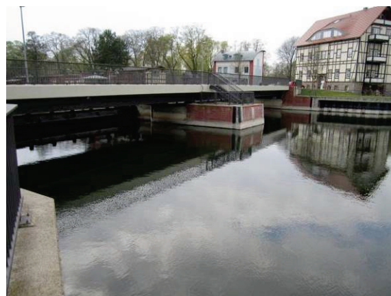
Abbildung 66: Wehr und Straße bei 1+200
