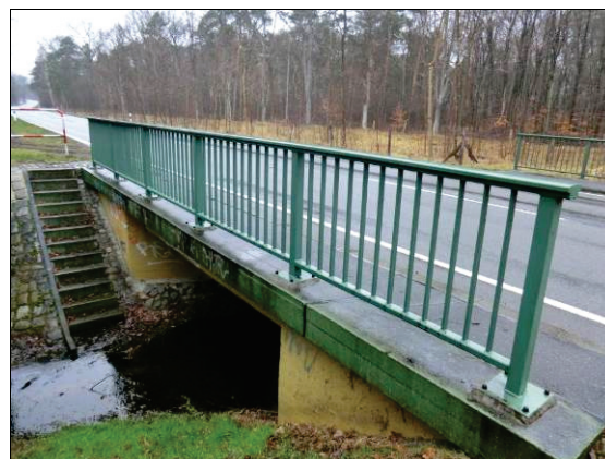
Abbildung 51: Straßenbrücke B102 (P02)
