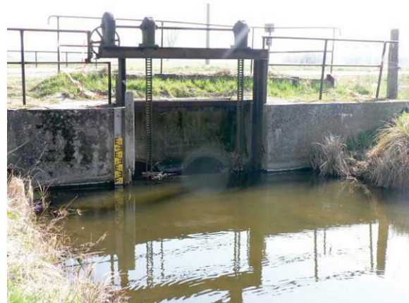
Abbildung 72: Wehr mit Doppeldurchlass unterhalb des Buckower Sees (P03)
