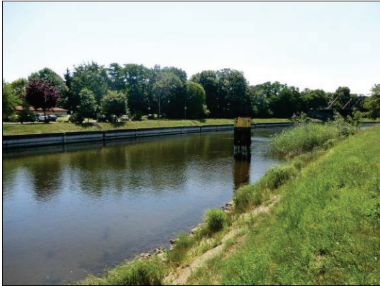
Abbildung 38: Schleuse in Rathenow
