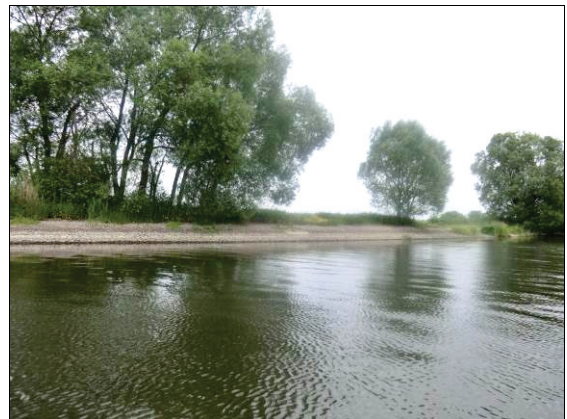
Abbildung 41: Wasserbauschotter am Ufer
