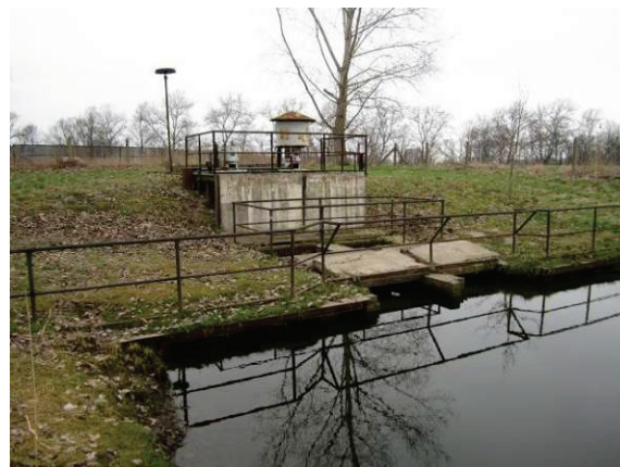
Abbildung 78: Schöpfwerk Albertsheim (P01)
