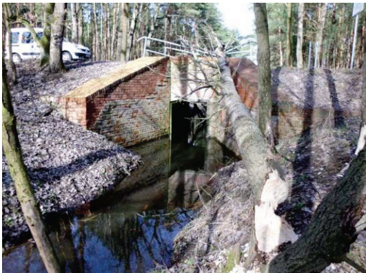
Abbildung 94: P05 Absperrbauwerk im Deich
