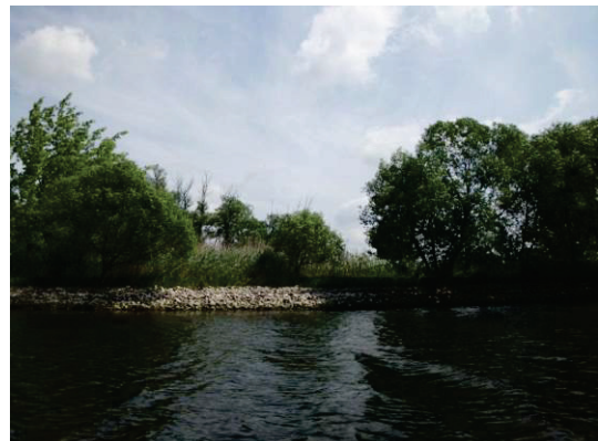
Abbildung 43: offenes Deckwerk, Planungsabschnitt P24
