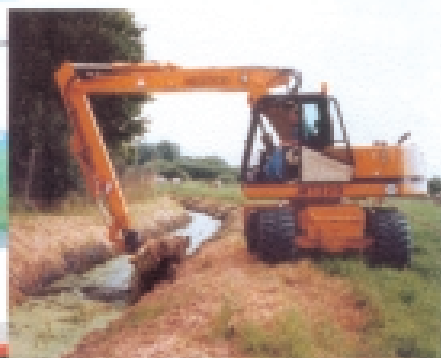
Hydrema Mobilbagger (geringes Eigengewicht bei Auslage über 10 m)
