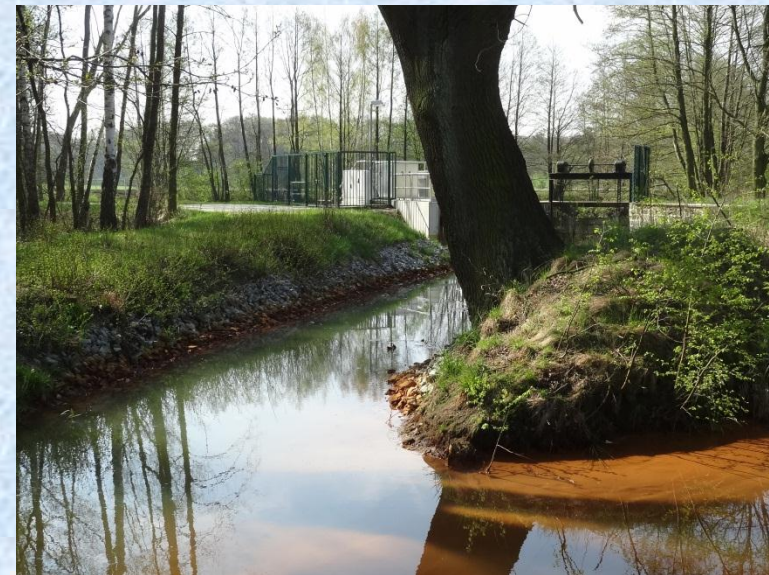
Wehranlage in der Berste bei Freesdorf und Berste uh Schöpfwerk Beesdau- verschlammmt
