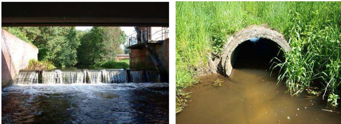
Abbildung 8: Fehlende Durchgängigkeit an der Stepenitz am Wehr Putlitz (links) und fehlendes Substrat eines Rohrdurchlasses an der Panke.
