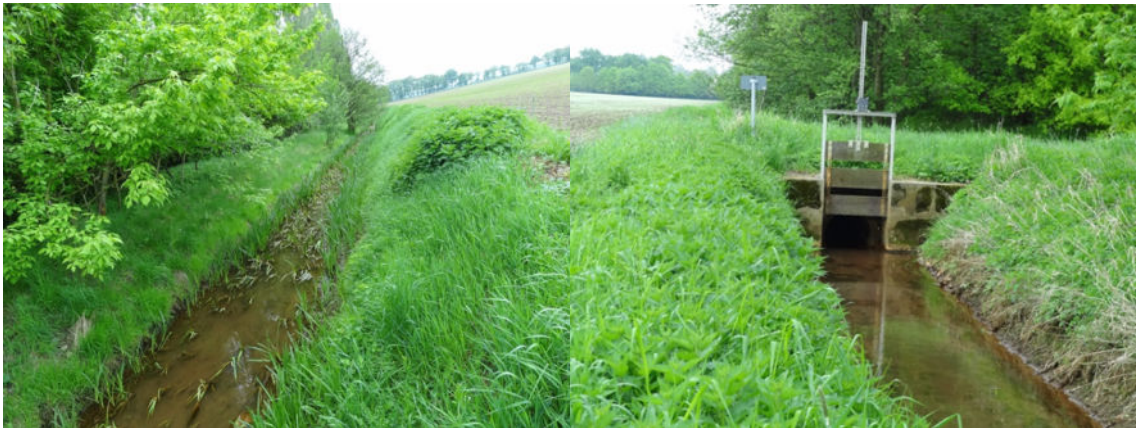
Abb. 5-16: Beke- eingetieftes Profil bei km 5+700 und Durchlass mit Staumöglichkeit bei km 5+800
