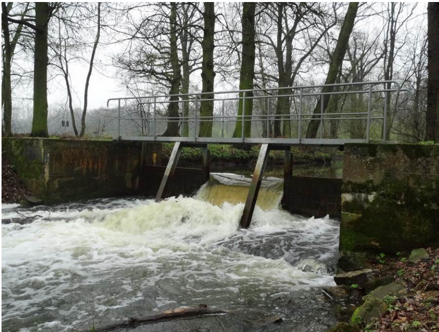
Abb. 8-10: Wehranlage in der Berste bei Reichwalde
