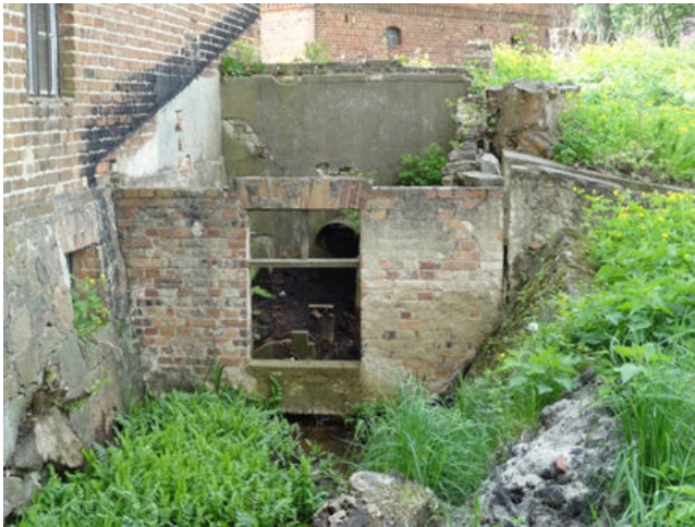
Abb. 5-13: Paseriner Mühlenfließ- Verrohrung bei Mühle Paserin, km 7+600
