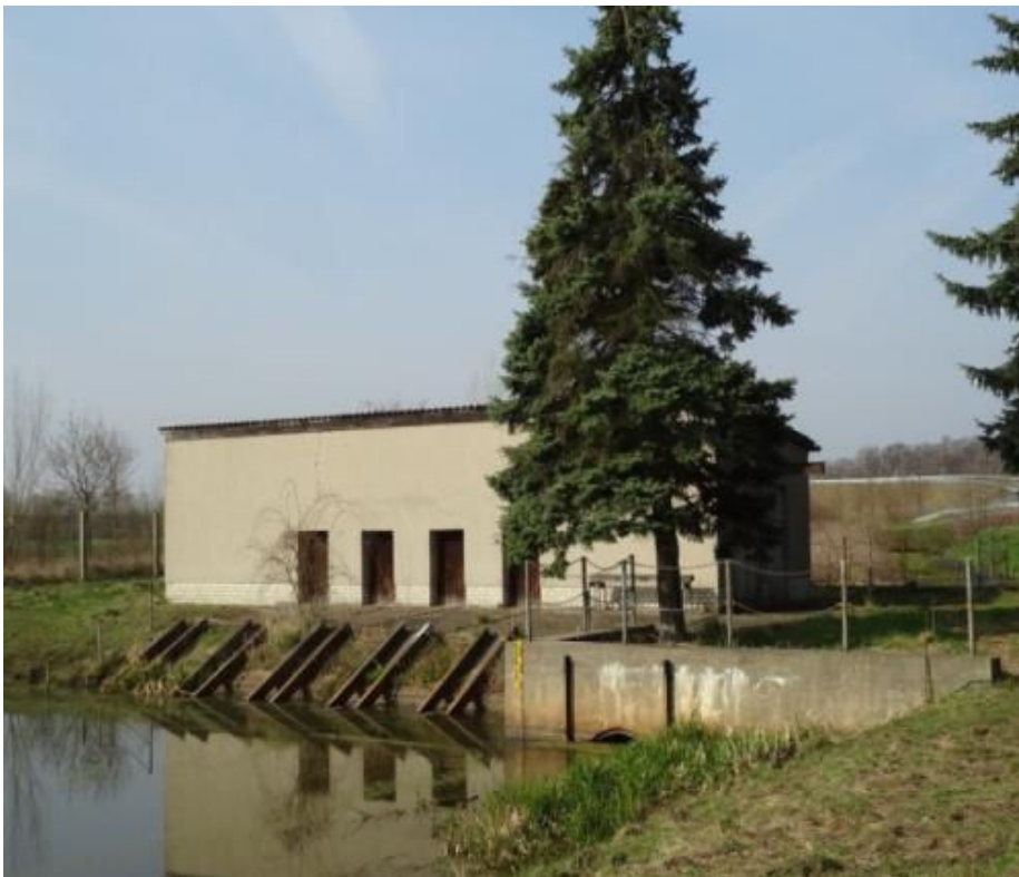
Abb. 5-22: Cahnsdorfer Fließ, km 0+400, Schöpfwerk ist stillgelegt
