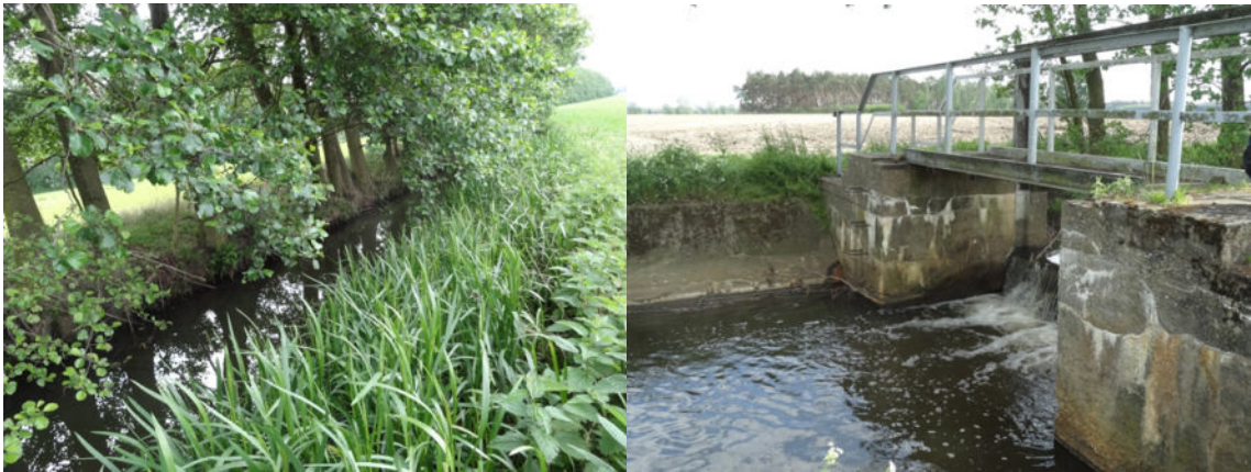
Abb. 5-10: Schuge bei km 6+200 und Wehr bei km 0+460
