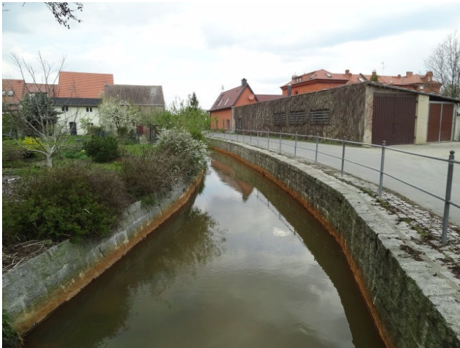
Abb. 8-28: verbauter Kohlegraben am Ortseingang von Luckau
