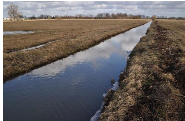
Grenzgraben Dürrenhofe (Station 5.200 - 5.300, Strukturgüteklasse 4)
