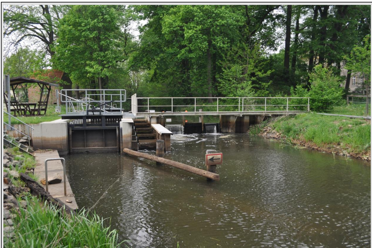
Abbildung 10: Schleuse bei Pretschen
