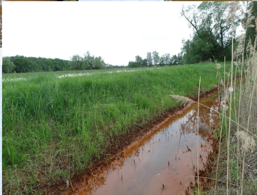
Ständergraben, oh Gewässerkreuzung
