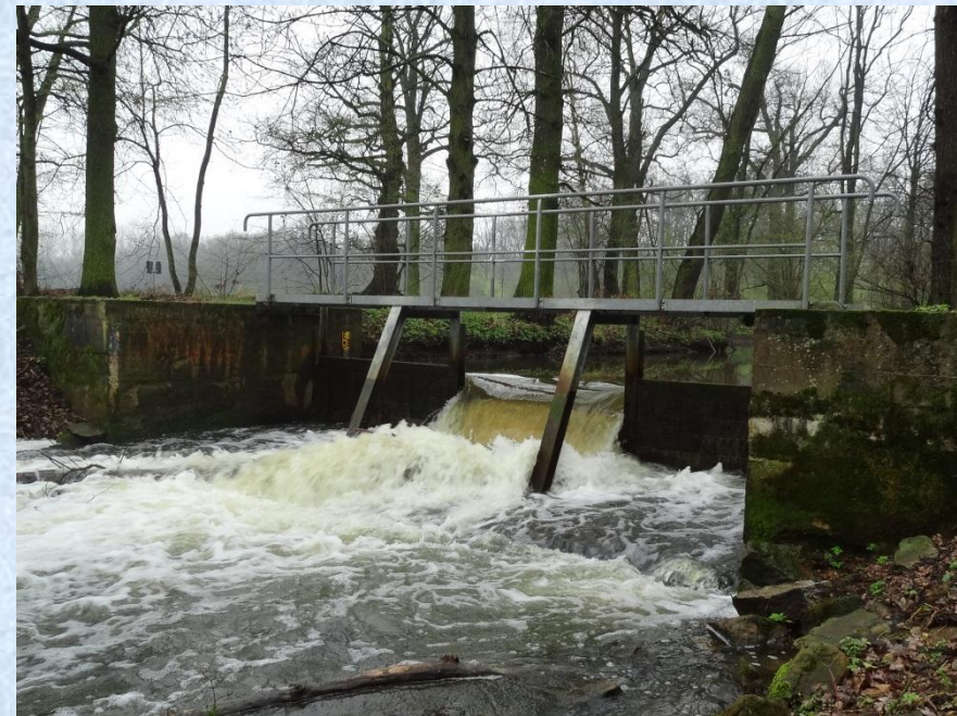
Wehranlage in der Berste bei Reichwalde
