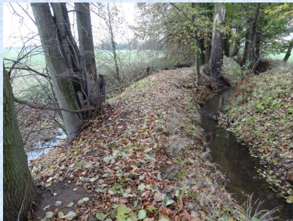
Gewässerbett liegt über Geländeneiveau- Gehrener Berste
