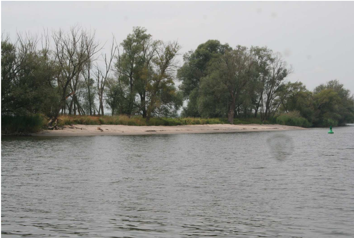
Uferaufspülung am Gleithang – Material aus der Fahrrinnenbaggerung
