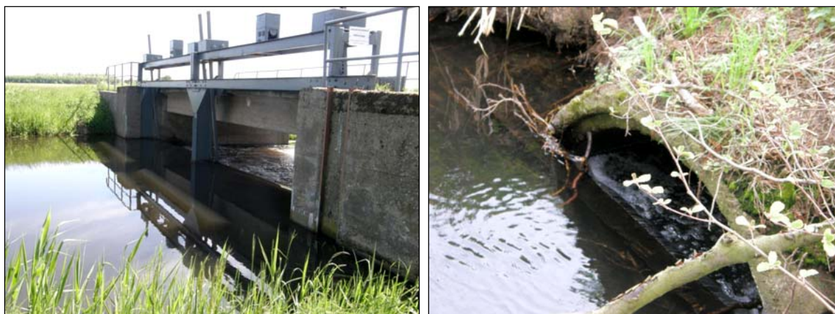
Abbildung 12: links: ökologisch nicht durchgängiges Wehr Schönefeld (Nieplitz), rechts: im Schlachter Mühlengraben nur für Fische durchgängiger Straßendurchlass
