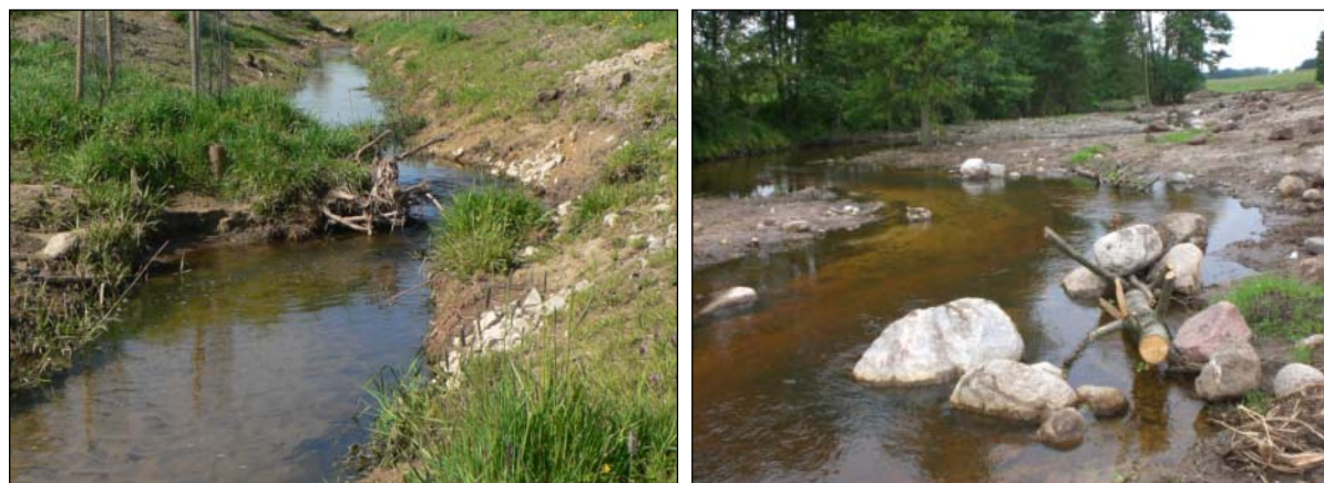
Abbildung 20: Beispiel zur Einbringung von Habitatelementen – links: Wurzelstubben; rechts: Störsteine und befestigte Baumstämme
