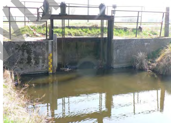
Abbildung 62: Wehr mit Doppeldurchlass unterhalb des Buckower Sees (P03)
