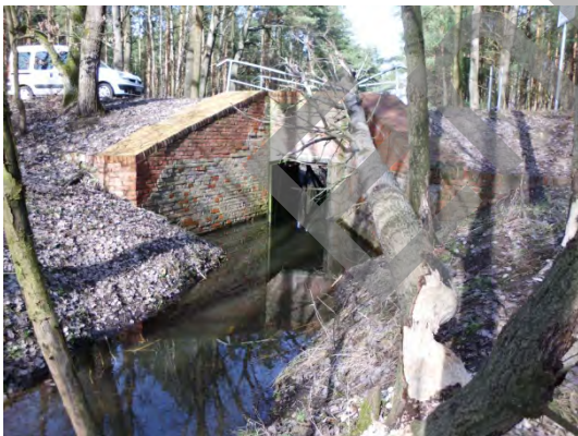
Abbildung 84: P05 Absperrbauwerk im Deich
