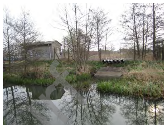
Abbildung 23: Pumpwerk in den Königsgraben
