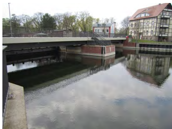
Abbildung 56: Wehr und Straße bei 1+200
