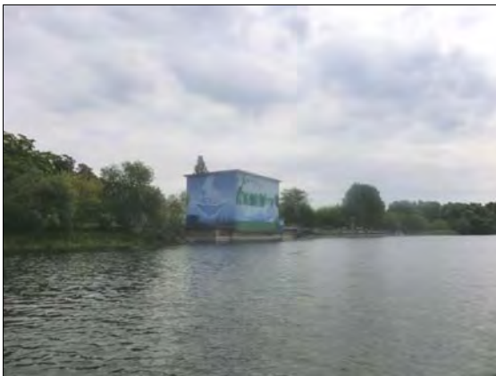
Abbildung 30: Pumpwerk in Premnitz
