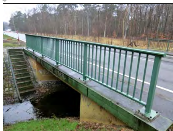
Abbildung 41: Straßenbrücke B102 (P02)
