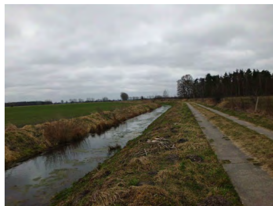
Abbildung 76: Abschnitt P04, niedrige Wasserstände mit umliegender ackerbaulichen Bewirtschaftung
