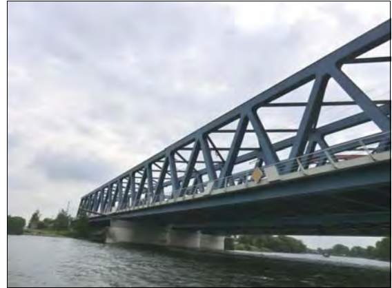
Abbildung 29: Eisenbahnbrücken I und II sowie Straßenbrücke B189 (Rathenow)
