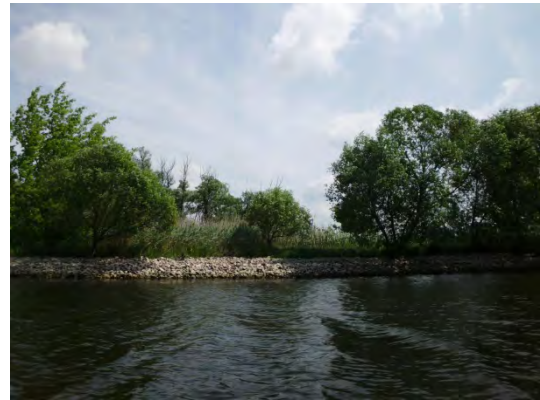
Abbildung 33: offenes Deckwerk, Planungsabschnitt P24
