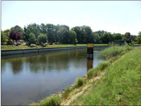
Abbildung 28: Schleuse in Rathenow
