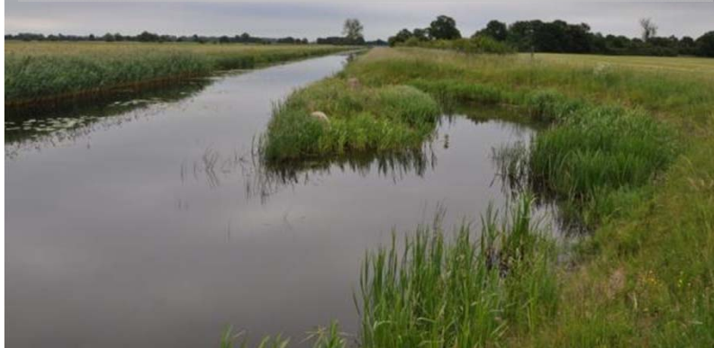
Bestehende Uferaufweitung bei stat. km 10+200
