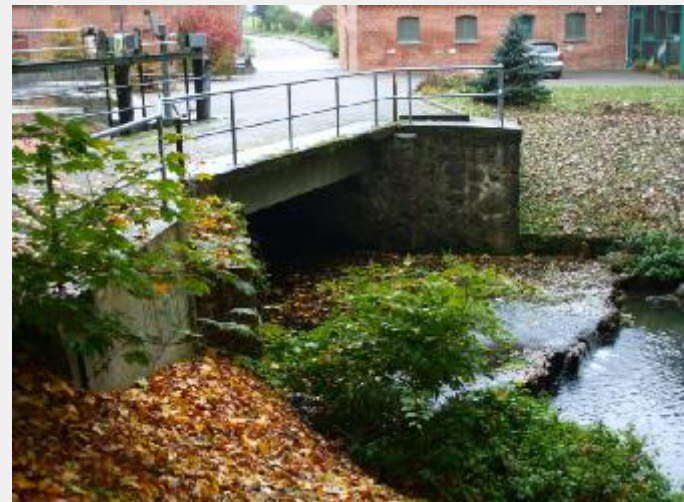
Wehr Kathfelder Mühle, Pritzwalk
