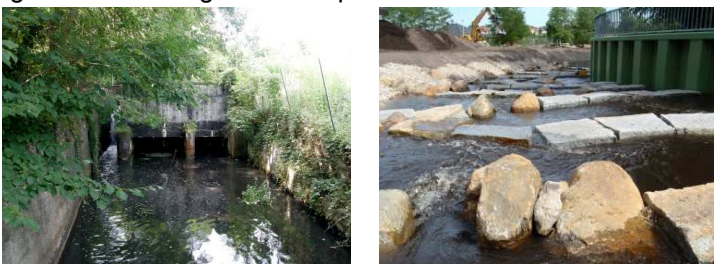
Wehr Elsthal vor (li) und nach Umgestaltung in eine Sohlgleite (re)
