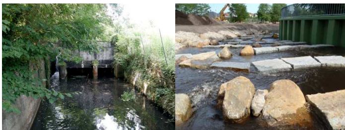
Wehr Elsthal vor (li) und nach Umgestaltung in eine Sohlgleite (re)
