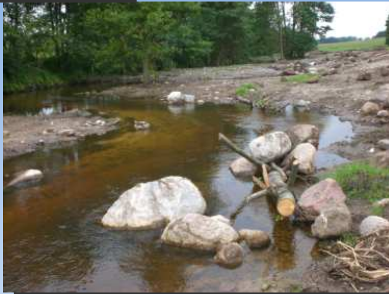
eingebraachte Störsteine und befestigte Baumstämme
