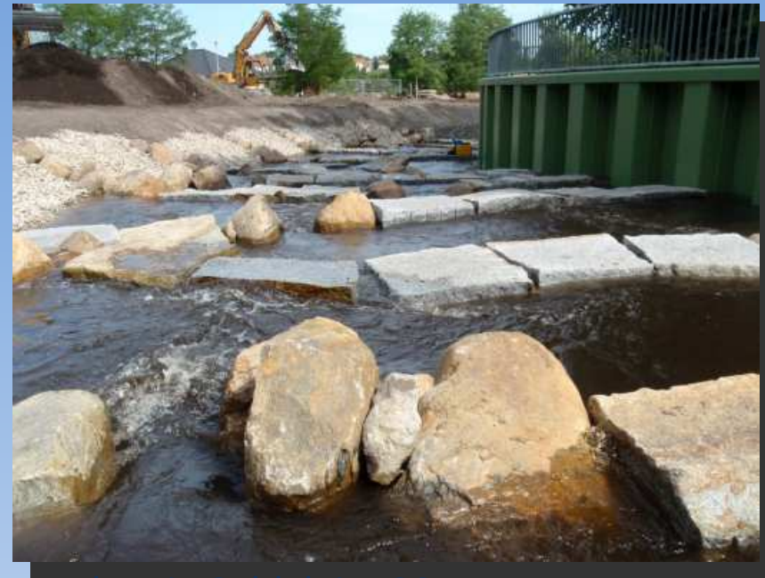
Umbau in Sohlgleite 2011
