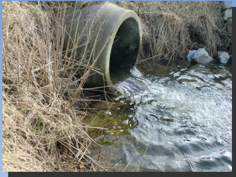
Durchlass ohne Substrat, mit Absturz
