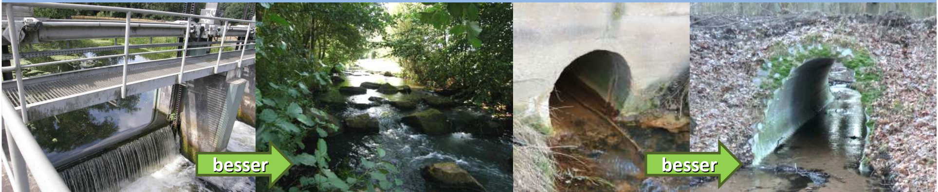
Wehranlage mit hohem Absturz
