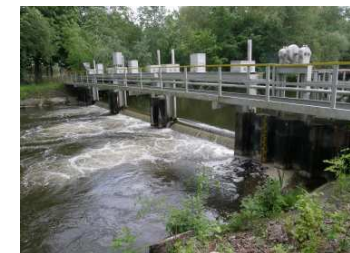
Wehr mit integrierter Fischaufstiegsanlage im Rottstocker Kanal (li); Wehr Blankensee ohne Möglichkeit für Fische auf- oder abzuwandern (re)
