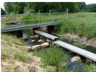
Wehr mit integrierter Fischaufstiegsanlage im Rottstocker Kanal (li); Wehr Blankensee ohne Möglichkeit für Fische auf- oder abzuwandern (re)
