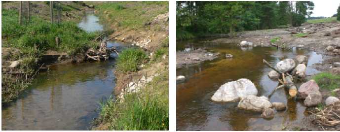
Beispiel zur Einbringung von Habitatelementen (li) Wurzelstubben; (re) Störsteine und befestigte Baumstämme (MK3)
