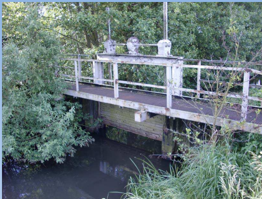
Bardenitzer Fließ, Wehr Wendewasser: Stauanlage durch raue Rampe/ Gleite ersetzen.
