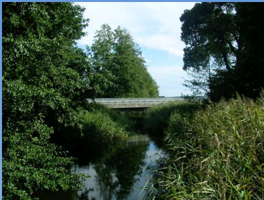
Nieplitz, Brücke Bundesstraße B2: Keine Maßnahme.
