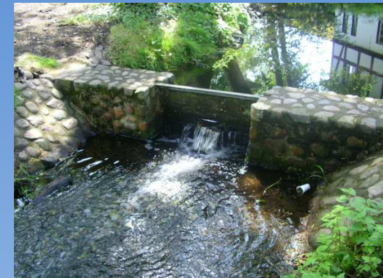
Nieplitz, Wehr im Park: Stauanlage durch raue Rampe/ Gleite ersetzen.
