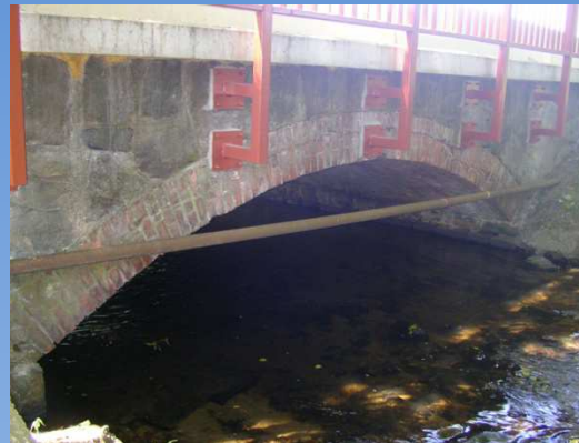
Nieplitz, Brücke L 851: Einbau von Steinen für Otterpassierbarkeit
