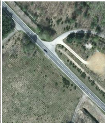
Abb. 4.2: 135m Verrohrung des Neuen Buchholzer Fließ an der L 52
