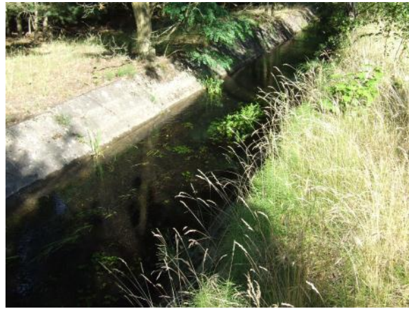
Sohlbefestigung am Neuen Buchholzer Fließ
