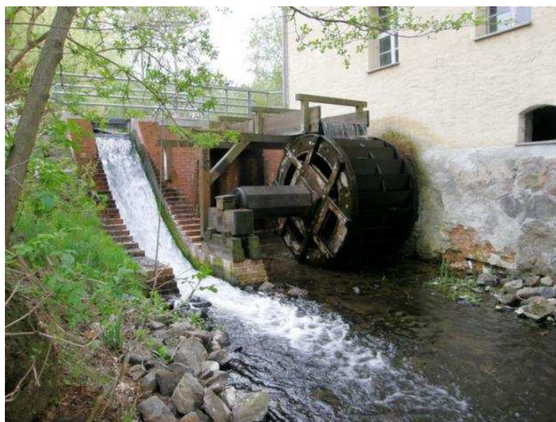
Abbildung 5-53: rekonstruierte ehemalige Mühle im Schlalacher Graben
