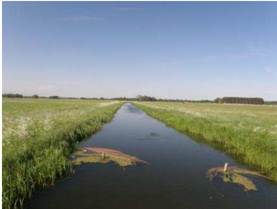
Abbildung 5-43: Brück-Neuendorfer Kanal, oberhalb des Wehres Schäpe
