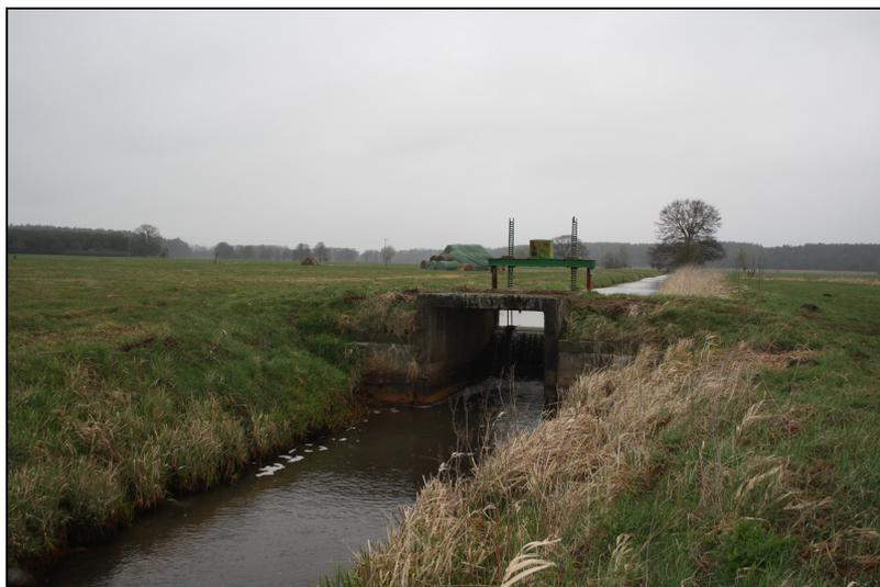
**Abbildung 16:** Nicht durchgängiger Fließgewässerabschnitt der Karthane bei km stat. 41+200 mit einem hohen Absturz durch die Stauhaltung (Foto: FuK, 07.04.2012)
