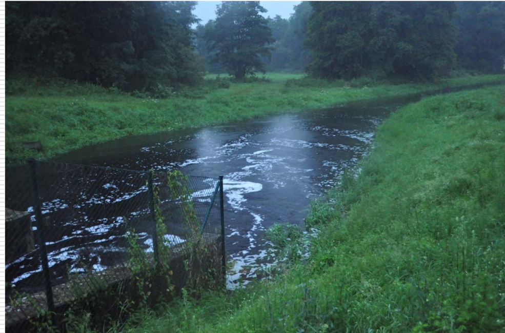
KA-Ableiter Foto IPS, 30.7.2011, 20:40
