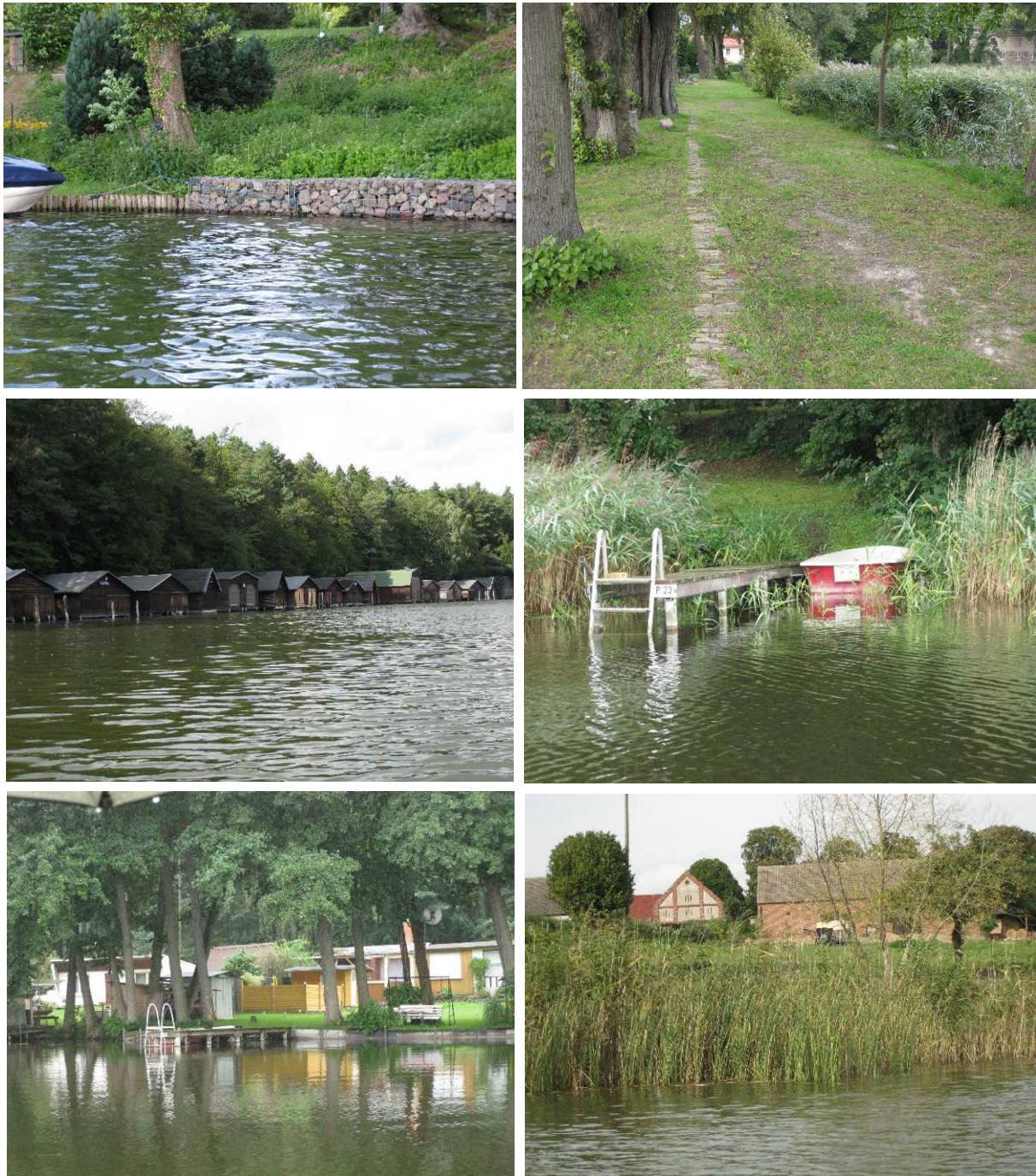
Abbildung 63: Beispiele für typische Schadstrukturen in der Eulitoralzone: oben links – senkrechter Uferverbau durch Schotterkörper und Palisaden ( I_{Obj} = 4,0 , Ruppiner See); oben rechts – Uferaufschüttung zur Erweiterung der Freizeitnutzung, die ältere Ufermauer ist noch deutlich zu erkennen ( I_{Obj} = 5,0 , Wutzsee); mitte links – Reihe von Bootshäusern auf Pfählen ( I_{Obj} = 4,0 , Gr. Schlabornsee); mitte rechts – einer von zahllosen kleinen Privatstegen am Ufer ( I_{Obj} = 3,4 , Zermützelsee); unten links – Wochenendhaus-siedlung ( I_{Obj} = 4,0 Zermützelsee); unten rechts – Bebauung dörflicher Prägung, die bis zur Uferlinie reicht ( I_{Obj} = 3,5 , Vielitzsee); Fotos: W. Ostendorf 2010 u. 2011.
