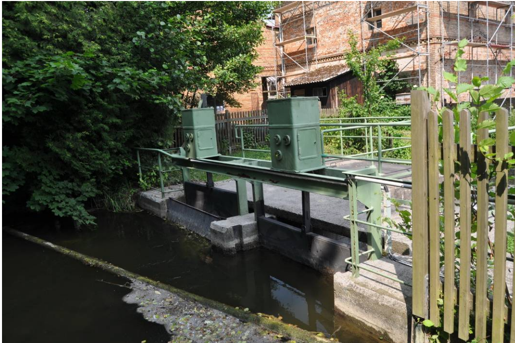
Abbildung 13: Auslaufbauwerk am Grienericksee (Rheinsberg)
