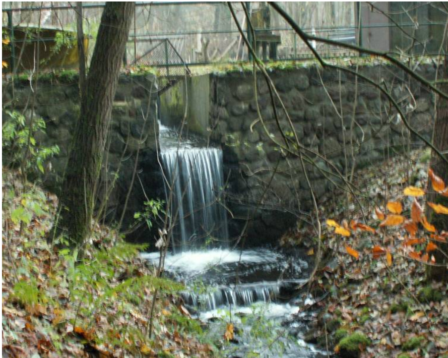
Abbildung 99: Sohlabsturz (asg01) an der Fischzuchtanlage im Abschnitt Ku_02
