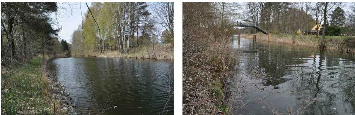
Abbildung 31: Der Kanal bei km 1,1 (Bild links) und bei km 4,2 (Bild rechts), jeweils stromaufwärts
