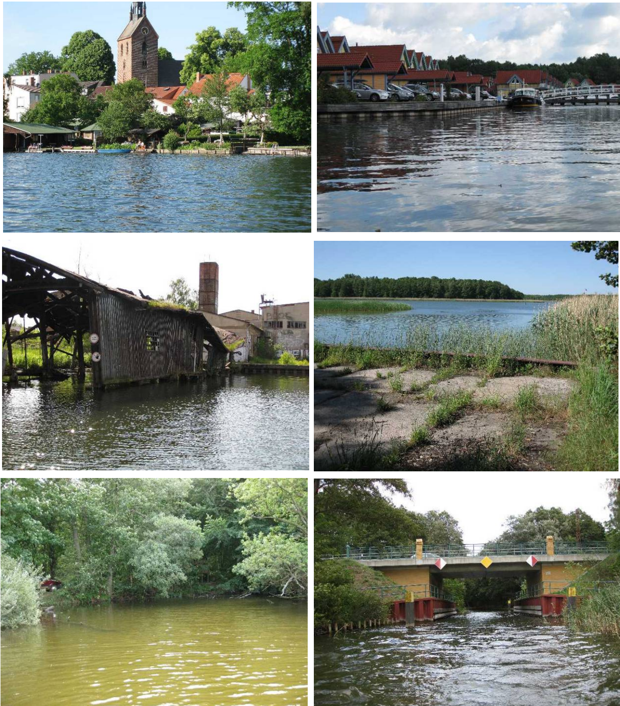
Abbildung 67: Beispiele für typische Schadstrukturen (Siedlung, Industrie) in der Epilitoralzone: oben links – städtische Bebauung ( I_{Obj} = 4,0 , Ruppiner See); oben rechts – nicht mehr genutzter Verladequai ( I_{Obj} = 5,0 , Bützsee); mitte links – Industriebrache in Neuruppin ( I_{Obj} = 4,5 , Ruppiner See); mitte rechts – komplexe Anlage, Marina „Hafendorf Rheinsberg“ ( I_{Obj} = 5,0 , Rheinsberger See); unten links – ehemal. Ausfluß des Schlaborensee, abgedämmt durch einen Straßendamm ( I_{Obj} = 5,0 , Kl. Schlaborensee); unten rechts – Kanaleinführung mit Seitendämmen, Spundwänden, Straßendamm und Aufschüttungen ( I_{Obj} = 4,0 und 4,5 , Gr. Schlaborensee); Fotos: W. Ostendorf 2010 u. 2011.
