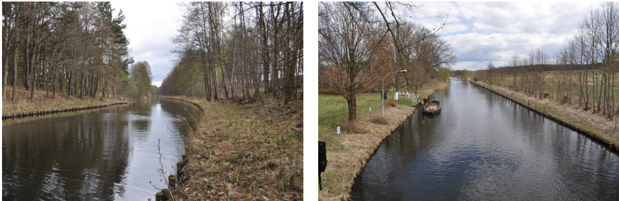
Abbildung 30: Hüttenkanal bei km 0,6 (Bild links) und bei km 2,0 (Bild rechts), jeweils stromaufwärts
