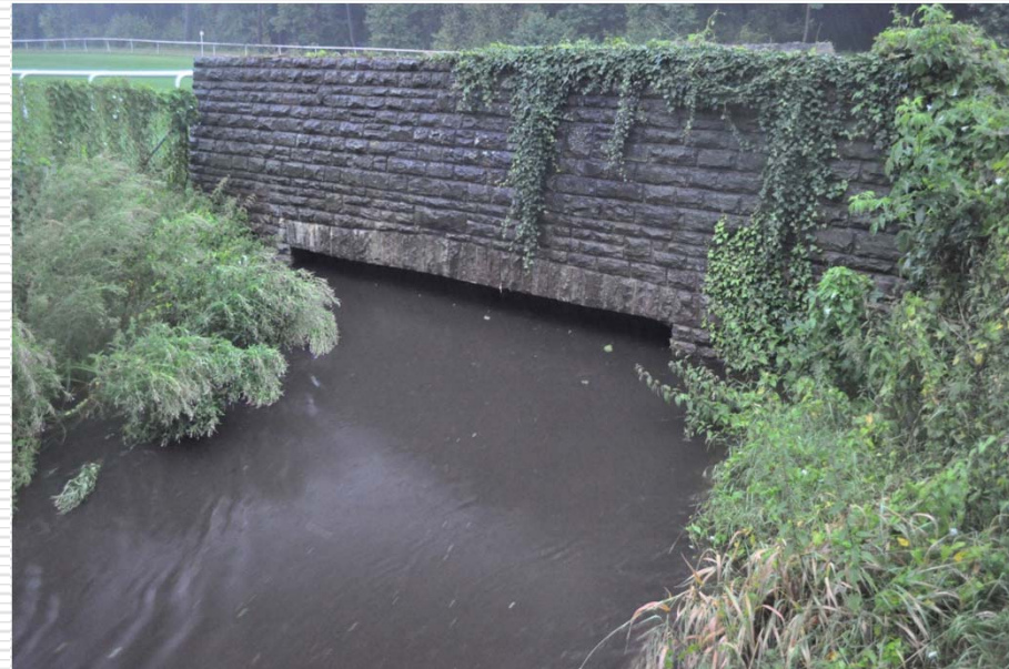
Erpebrücke, Rennbahnallee Foto IPS, 30.7.2011, 20:30
